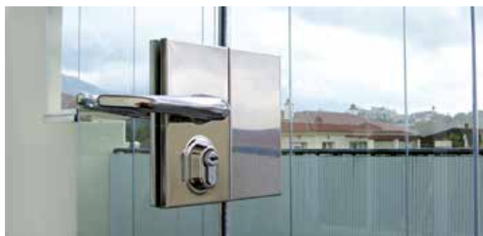
Serrure sur le premier vantail avec double béquille
